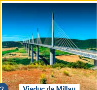
Viaduc de Millau
