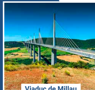
Viaduc de Millau
